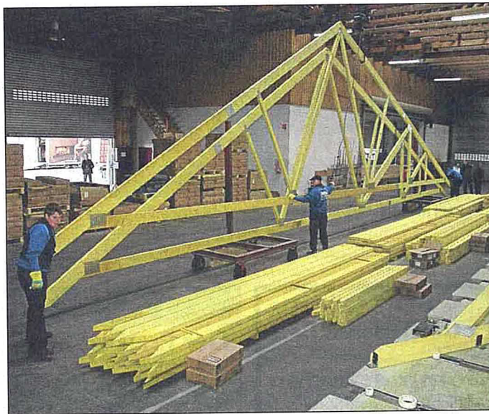
Mitarbeiter von Jura-Holzbau fertigen einen Dachstuhl.
