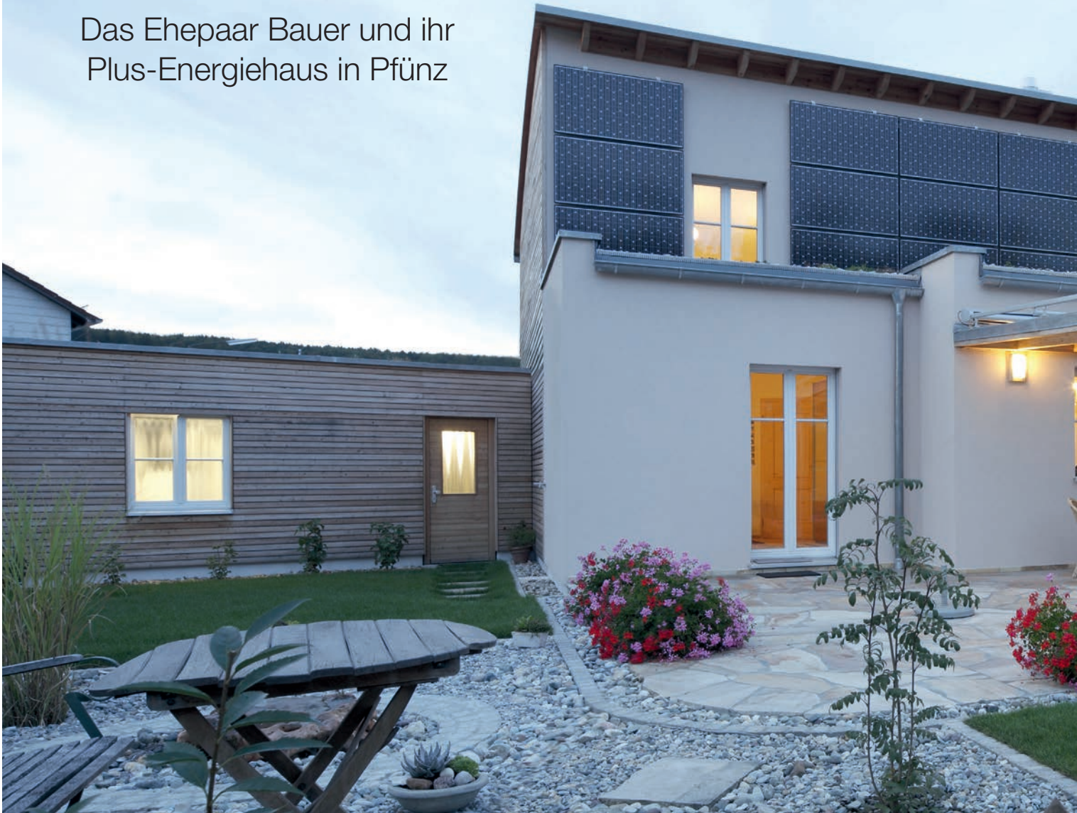
Fotos: JURA-HOLZBAU GmbH
