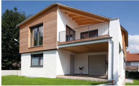
Dachaufstockung durch JURA-HOLZBAU
