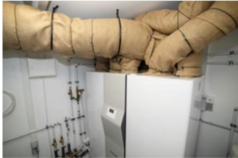
Nur ein Gerät sorgt für Heizung, Lüftung und Trinkwassererwärmung. Die Luftkanäle sind mit Jute-Dämmmatten isoliert. Sieht unkonventionell aus, ist aber nachhaltig und praktisch.
