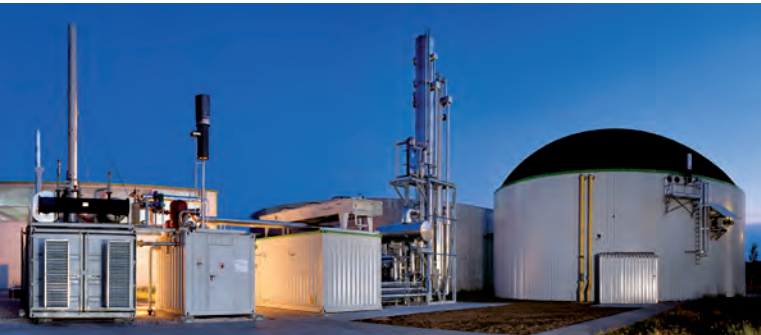
Die Schmack Biogas AG in Schwandorf, die größte Biogasanlage Europas. Hier kamen die Nagelplattenbinder von JURA HOLZBAU zum Einsatz.
