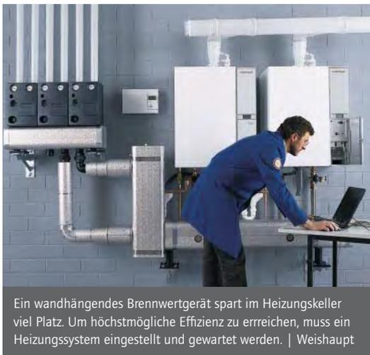
Ein wandhängendes Brennwertgerät spart im Heizungskeller viel Platz. Um höchstmögliche Effizienz zu erreichen, muss ein Heizungssystem eingestellt und gewartet werden. | Weishaupt
