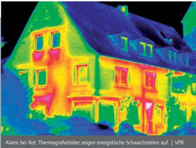
Alarm bei Rot: Thermografiebilder zeigen energetische Schwachstellen auf. | VPB
