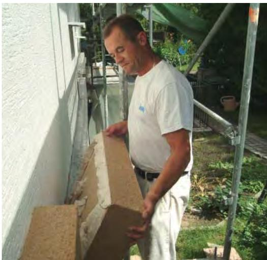
Ideal für die Sanierung: Wärmedämmverbundsystem | Knauf
