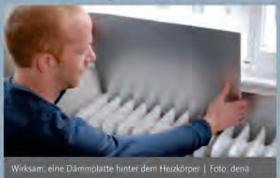
Wirksam: eine Dämmplatte hinter dem Heizkörper | Foto: dena
