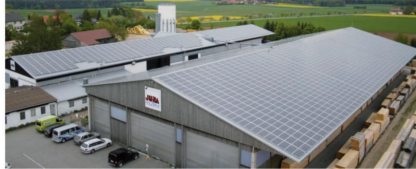
Die neue PV-Anlage mit einer Nettofläche von 4100 qm, einer Leistung von 515 kWp und einer Stromerzeugung von 446.000 kWh.
