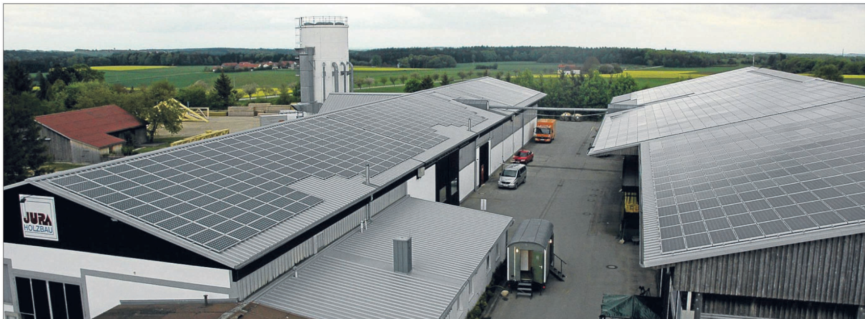
Über 4000 Quadratmeter Solarmodule wurden auf den Dächern der Firma Jura-Holzbau in Jachenhausen installiert.
