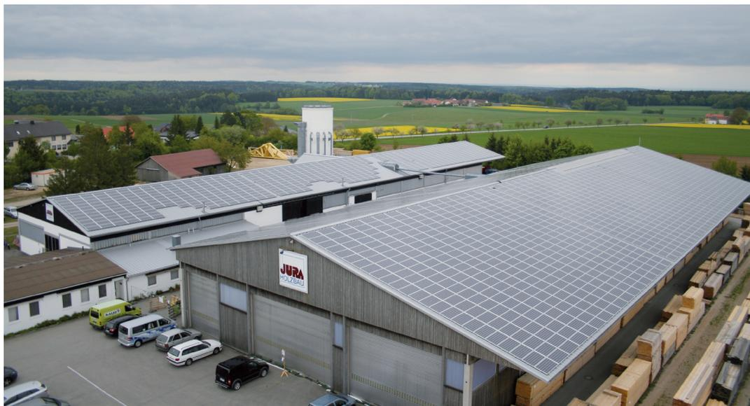
Die Photovoltaikanlage auf den Dächern der Produktionshallen von Jura Holzbau hat eine Gesamtfläche von 4100m<sup>2</sup> und erzeugt im Jahr rund 450.000 Kilowattstunden an Strom.
