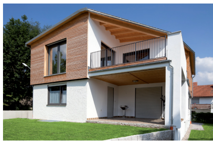
Hier nahm JURA-HOLZBAU eine Dachaufstockung vor.
