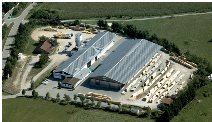
Das Firmengelände von JURA-HOLZBAU in Riedenburg.
