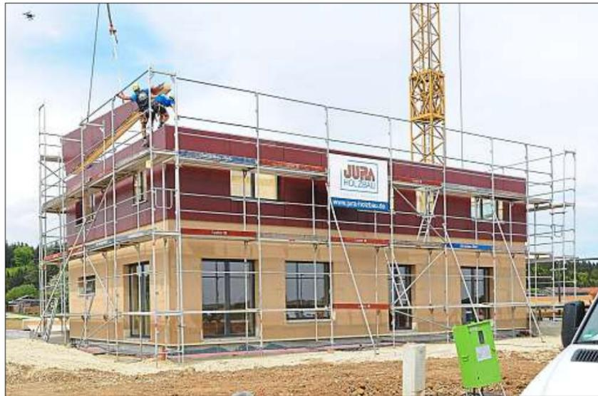
**Millimeter genau** werden die fertigen Wände, in denen die Fenster und Türen einmontiert sind, zusammengefügt. Am Ende eines Tages schließt das Dach das Haus ab. Sobald der Außenputz aufgetragen ist, verrät nur noch das angenehme Wohnklima das moderne Holzhaus. Fotos: Hierl
