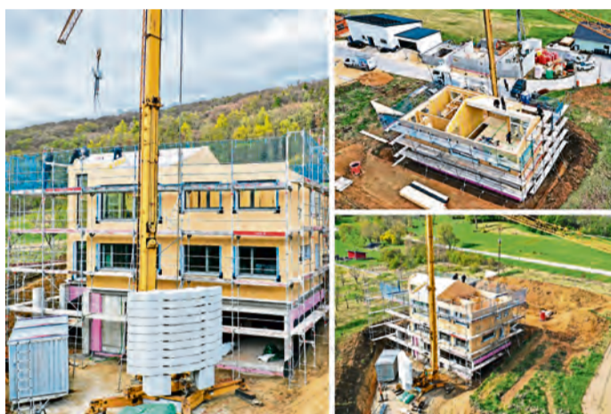
Durch die präzise Vorfertigung aller Elemente kann ein komplettes Wohnhaus an nur einem Tag auf dem vorbereiteten Fundament regen- und winddicht aufgestellt werden. Fotos: Lorenz Ertl/JURA-HOLZBAU GmbH
