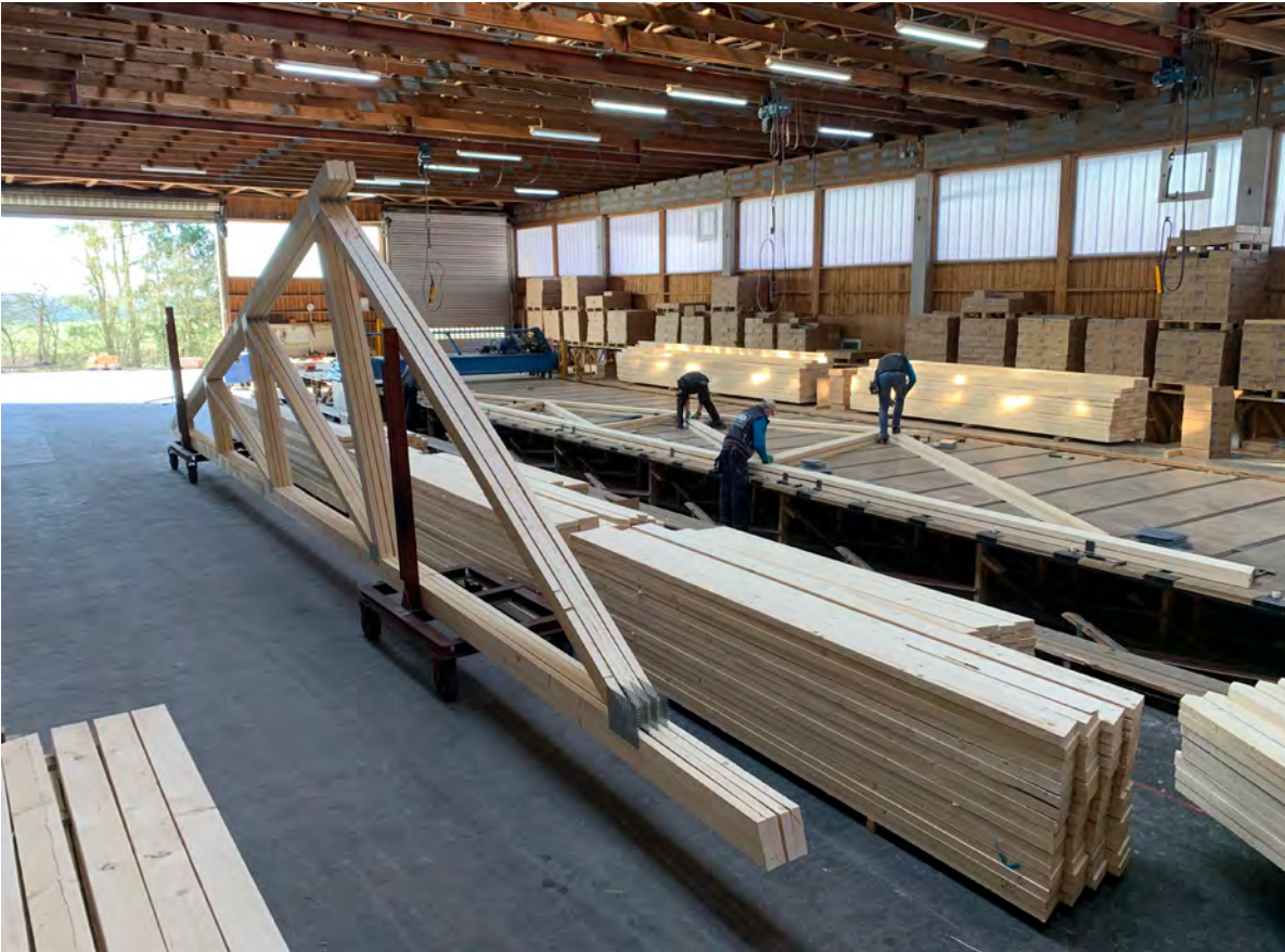
Manuelle Vorfertigung von Nagelplattenbindern in der Werkshalle des Unternehmens Jura Holzbau
