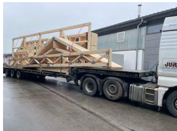
Der Binderhersteller liefert auf Wunsch den Bausatz für die neue Halle montagefertig auf die Baustelle
