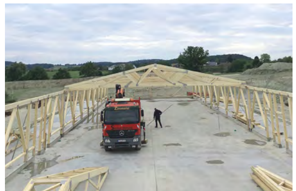
Nagelplattenbinder können auch im Wandbau eingesetzt werden, wenn die spätere Nutzung der Halle es zulässt, hier beim Bau eines Hühnerstalls Foto: Jura Holzbau GmbH
